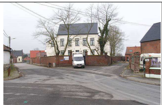
Photo 2 : Le presbytère après rénovation
