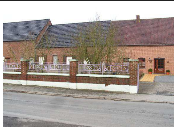
Photo 6 : Habitation donnant sur la place de l'Eglise
