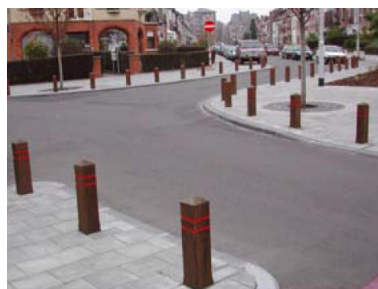
Le carrefour a été réduit par l'élargissement du trottoir. On remarque les bordures enterrées qui permettent une traversée à niveau très confortable.
