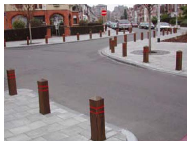
Le carrefour a été réduit par l'élargissement du trottoir. On remarque les bordures enterrées qui permettent une traversée à niveau très confortable.
