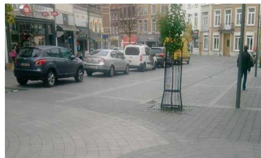
Figure 3 : Exemple de zone de rencontre (Tirmont)
